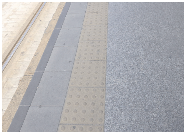
Rys. 7. Elementy dotykowe na przystankach tramwajowych w Warszawie: a) stare, b) nowe [fot. J. Poliński]
