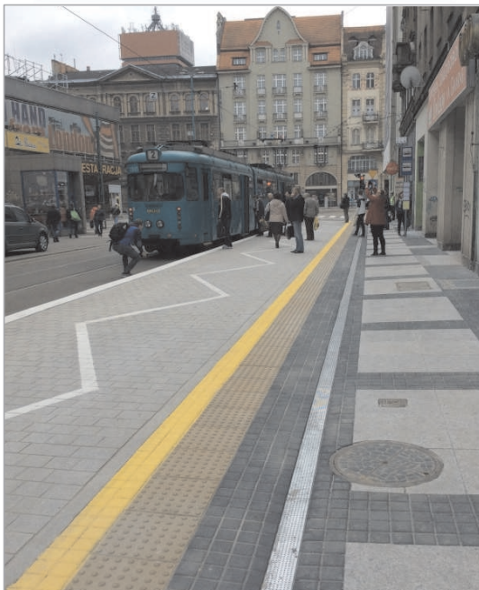
Rys. 2. Przykład peronu tramwajowego typu wiedeńskiego w Poznaniu [23]
