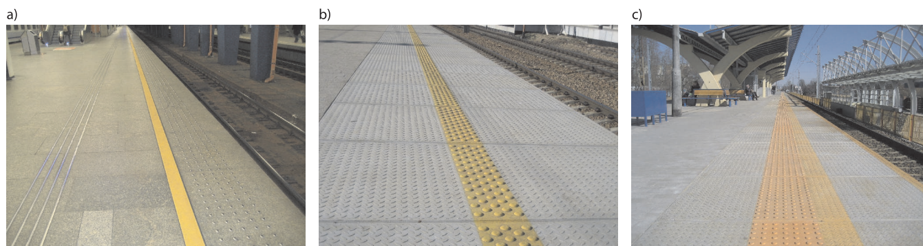
Rys. 5. Różne rozwiązania dotykowych pasów ostrzegawczych na peronach kolejowych w Warszawie: a) dworzec Warszawa Centralna (pas ostrzegawczy znajduje się w strefie zagrożenia), b) dworzec Warszawa Wschodnia (pas ostrzegawczy umieszczono na linii ostrzegawczej), c) przystanek Warszawa Ursus Niedźwiadek (pas ostrzegawczy znajduje się poza strefą zagrożenia) [fot. J. Poliński]
