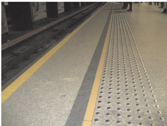
Rys. 4. Ujednolicone oznakowanie krawędzi peronów metra [fot. J. Poliński]
