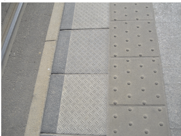
Rys. 7. Elementy dotykowe na przystankach tramwajowych w Warszawie: a) stare, b) nowe [fot. J. Poliński]
