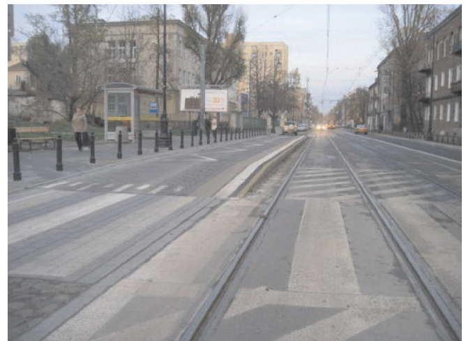
Rys. 3. Oznakowanie peronu tramwajowego typu wiedeńskiego w Warszawie [24]
