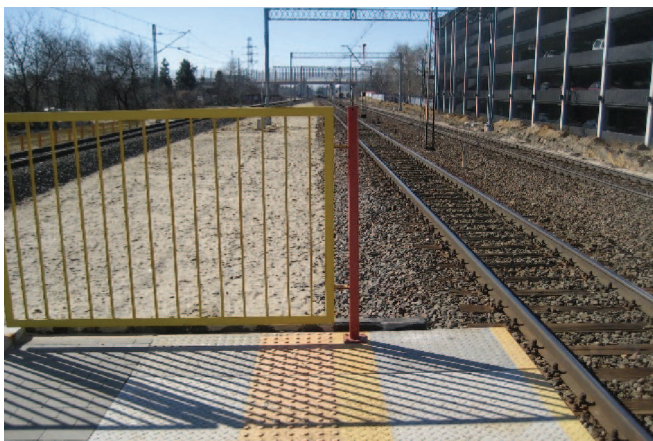
Rys. 3. Zabezpieczenie końca peronu [4]
