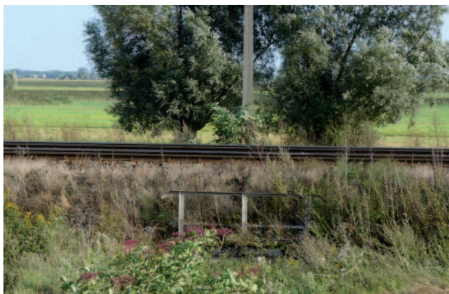
Rys. 7. Zasypany przepust pod torami [zbiory Zakładu Dróg Kolejowych i Przewozów Instytutu Kolejnictwa]
