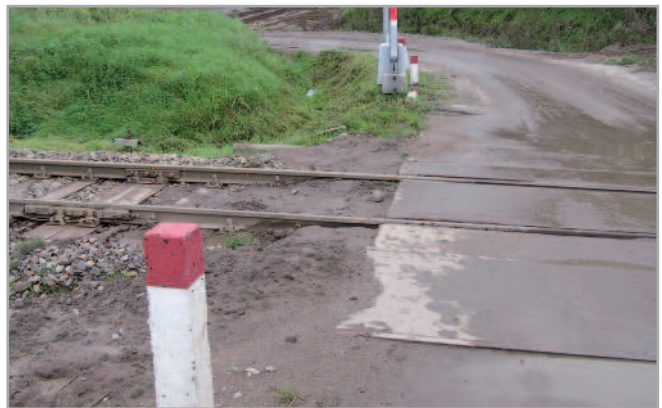
Rys. 13. Zanieczyszczenie nawierzchni kolejowej w rejonie przejazdu z powodu niewłaściwego odwodnienia [6]
