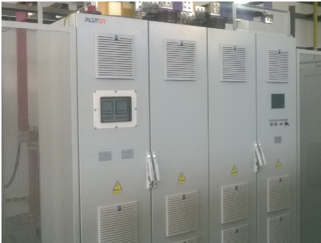
Rys. 21. Widok ogólny prostownika trakcyjnego V-TPED-2,0k-3,3k-12P-UHL4, produkcji firmy PLUTON [fot. W. Kruczek]
