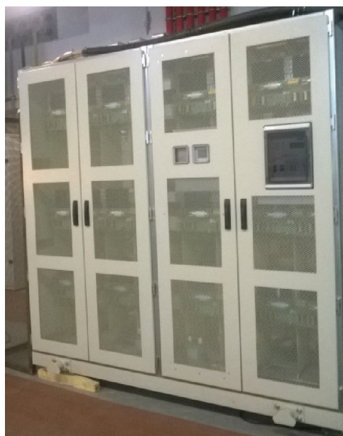
Rys. 11. Widok ogólny prostownika trakcyjnego PD17T/3,3 produkcji firmy TRAKCJA PRKiI S.A. [fot. W. Kruczek]
