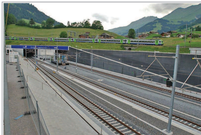
Rys. 2. Wjazd do tunelu Lötschberg [12]
