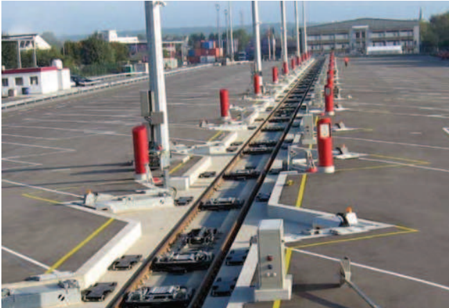
Rys. 3. Widok frontu ładunkowego terminalu z torem zagłębionym [10]
