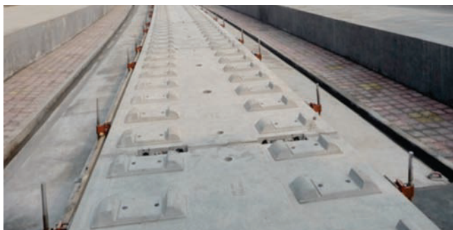
Rys. 8. Budowa linii kolejowej Cheng-Guang [16]
