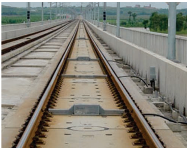
Rys. 5. Nawierzchnia z płyt na moście Guohe w Qin-Shen [16]
