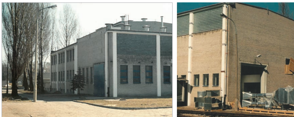
Rys. 1. Widok budynku hamowni podczas oraz montażu aparatury w 1997 r. [archiwum CNTK]
