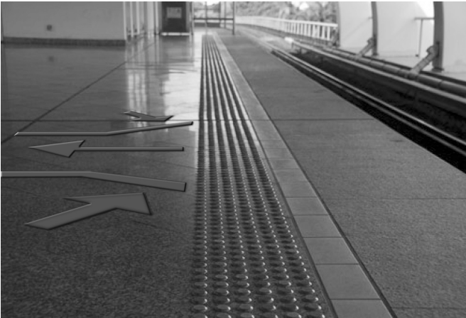
Rys. 1. Prawidłowe położenie dotykowych elementów ostrzegawczych wraz z zaznaczeniem miejsca położenia drzwi wejściowych do wagonu
