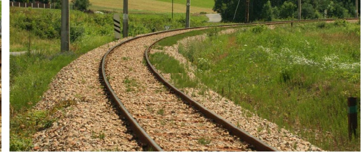
Rys.4 Podkłady stalowe typu Y z przytwierdzeniem sprężystym „SB”. Linia góraska.
