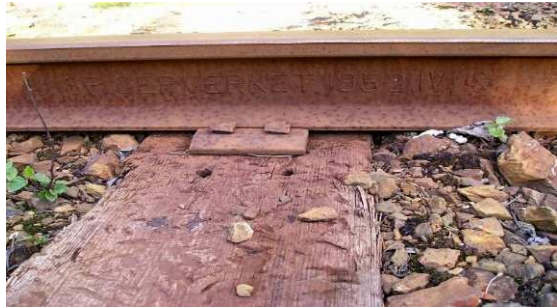
Rys.1 Podkłady drewniane z przytwierdzeniem hakowym. Linia znaczenia miejscowego.
