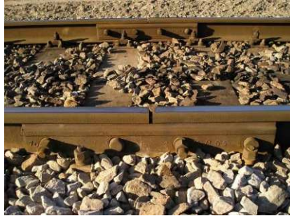
Rys.2 Podkłady drewniane, z przytwierdzeniem śrubowym „K”. Linia drugorzędna.
