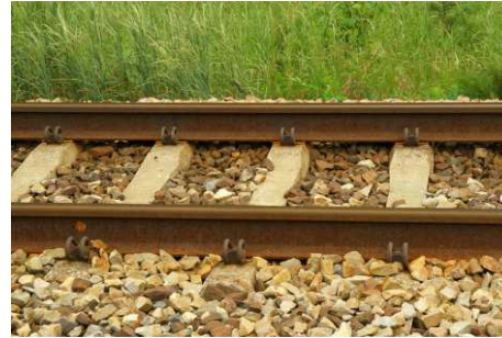
Rys.3 Podkłady betonowe, z przytwierdzeniem sprężystym „SB”. Linia magistralna.
