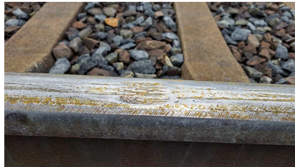
Rys.25 – 28 Uszkodzenia szyn w postaci „wybuksowania”
