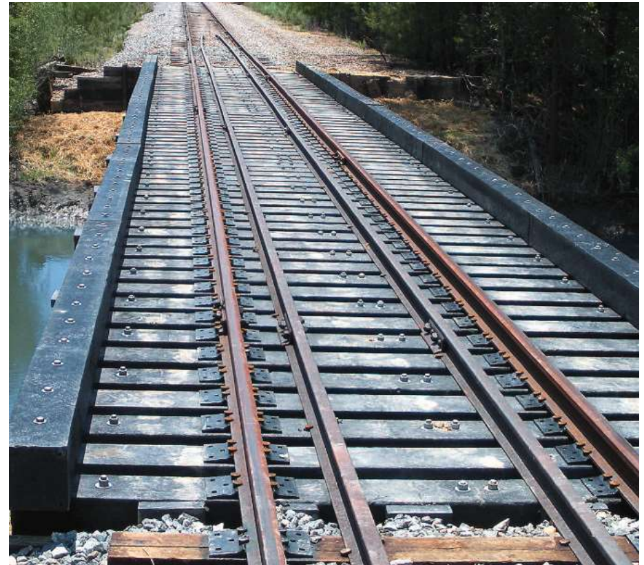
Kompozytowe podkłady kolejowe ECOTRAX™ zainstalowane na moście kolejowym w Fort Eustis w stanie Wirginia [broszura AXION]
